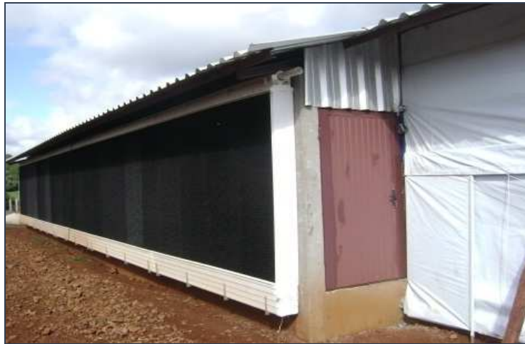
FIGURA 48 – “DOG HOUSE” EM SISTEMA DE RESFRIAMENTO POR PAD COOLING.
